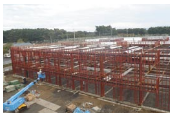
瑞光園新築工事(鉄骨工事)
