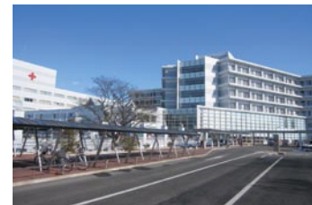
八戸赤十字病院建設工事
