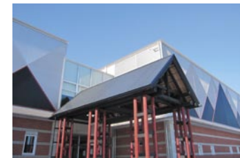
是川縄文館本棟工事
