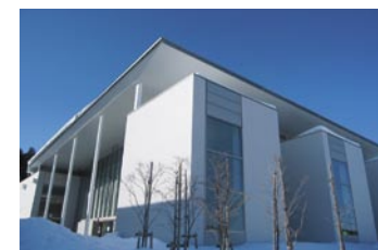
南郷文化ホール建設工事(建具工事)
