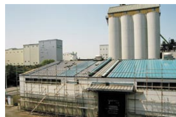
菜倉庫改修工事(カバールーフ工事)
